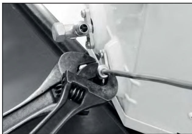
FIG. 41 - FIXAÇÃO DA PORCA
