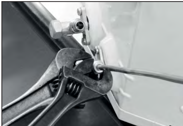
FIG. 38 - FIXAÇÃO DA PORCA
